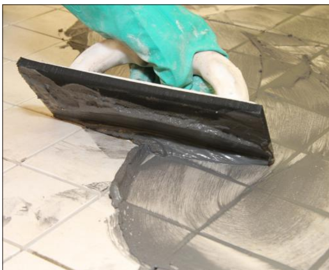
Fugiranje nevpojnih ploščicah (npr. fini granitogres) s Sopro DF 10°.
