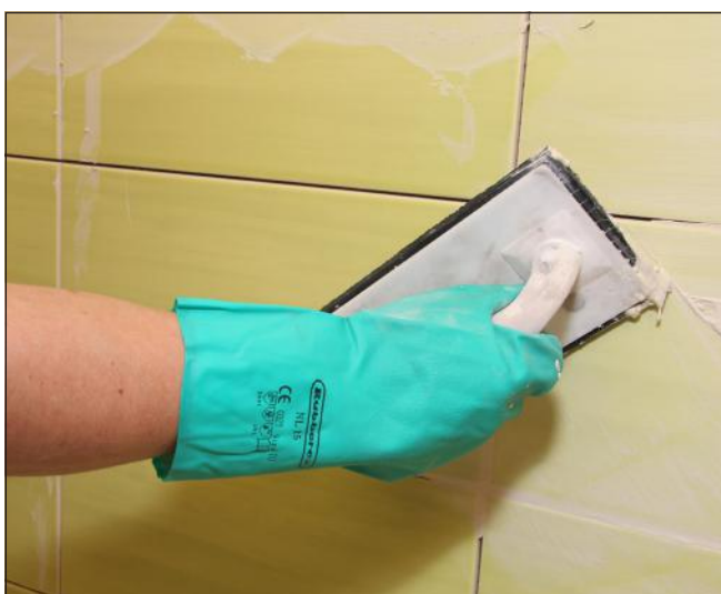
9 Fugiranje ploščic iz žgane lončevine s Sopro DF 10°.
